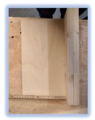
**Schritt 2**: Wenn alle Teile fertig sind, leimt sie auf die Grundplatte. Verleimt auch die Seitenteile mit Vor- und Rückwand und benutzt Leimklemmen oder Schraubzwingen, um die geleimten Stellen gut zusammenzudrücken.
